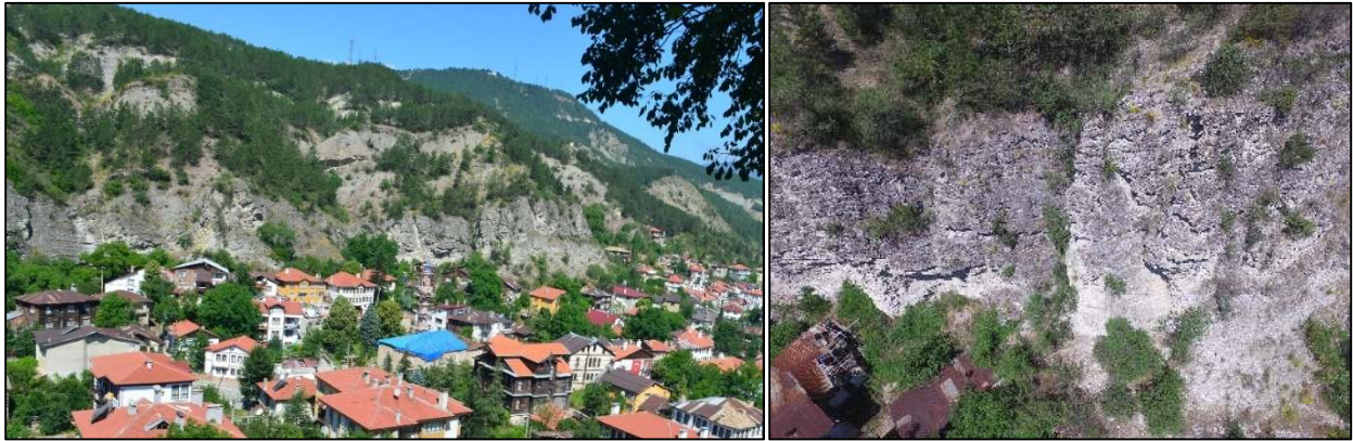
Şekil 1. Vadi yamaçlarındaki kireçtaşlarında süreksizlik düzlemlerini gösteren görüntü ve tehdit altındaki yapıların durumu
